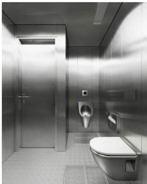
Отделка панелями из нержавеющей стали.
